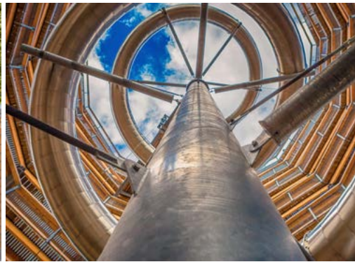
40 Meter hoch schraubt sich der Holzsteg.
